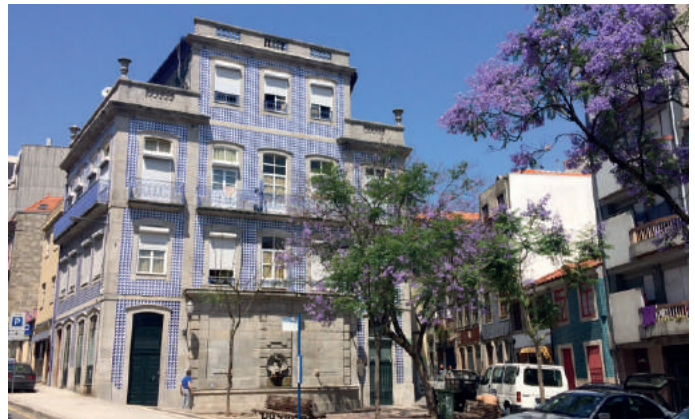
Fachada reabilitada, largo Gen. Silveira, Porto
