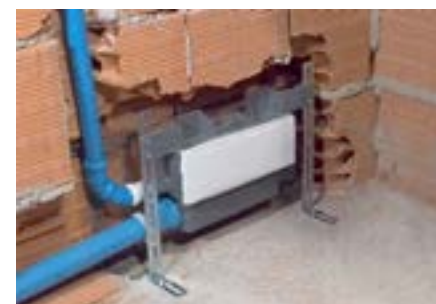
Aplicación en tabiquería de ladrillo
