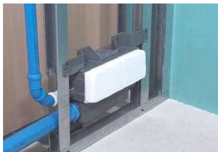
Aplicação em calha técnica
