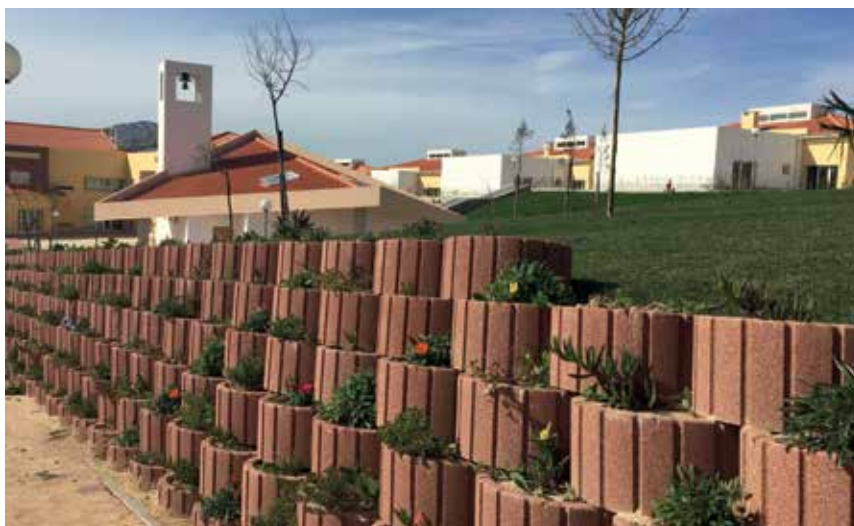
Bordeaux - Residencial Sênior - Arruda dos Vinhos
