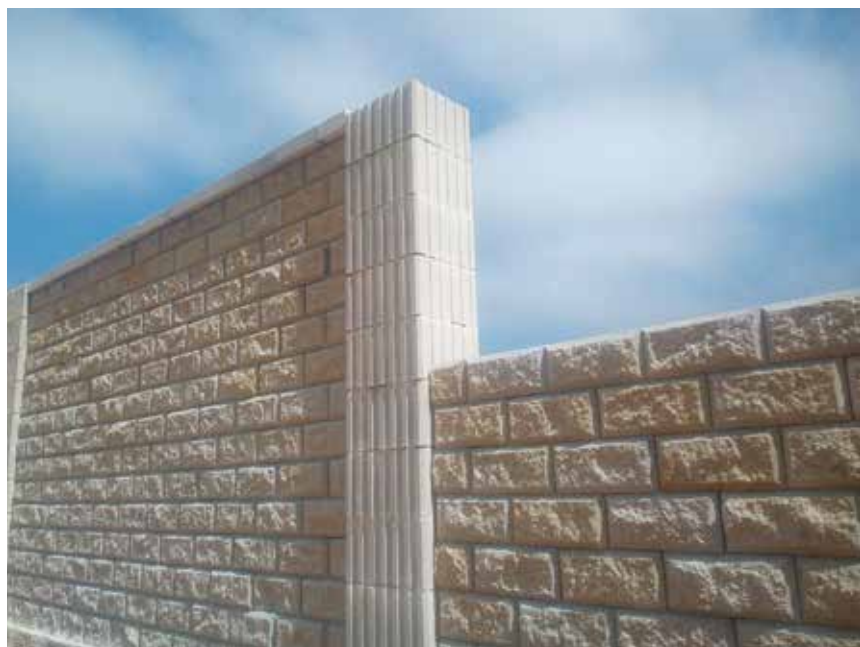
Pilar de Muro, Gardenbloco® e Cobremuro - Branco Integral - Aveiro
