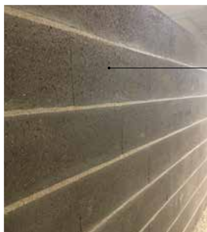
Estacionamento CGD - Parque das Nações - Bloco + Pilar + Lintel
