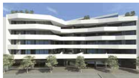
Edifício Boavista - Bragança
