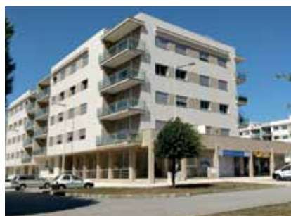
Edifício - Santa Maria da Feira
