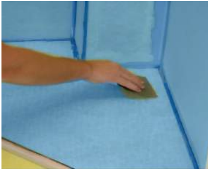
4 – Com uma espátula de cantos redondos, pressionar de dentro para fora ou de cima para baixo, para evitar a formação de bolhas ou de rugas na tela. Esta operação é indispensável para que o trabalho seja concluído com sucesso.
