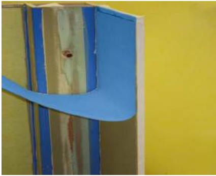
3 – Colocar a tela impermeabilizante ODEM, sobre o cimento cola. Em parede de cima para baixo. Em pavimentos do centro para as pontas deve ser deixado uma distância de 2cm em cada extremidade da tela, para poder corrigir alguma bolsa de ar que se forme.
