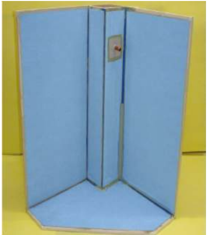
5 – Agora a superfície está impermeabilizada e pode-se começar o revestimento.
