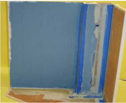
2 – Espalhar o cimento cola na superfície a impermeabilizar (cimento cola classe C2 mínima). Usar um pente com dentes de 4x4mm.
