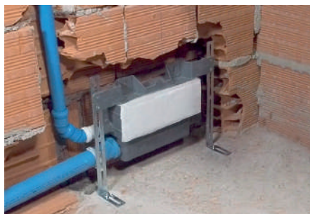
Aplicação em parede de alvenaria
