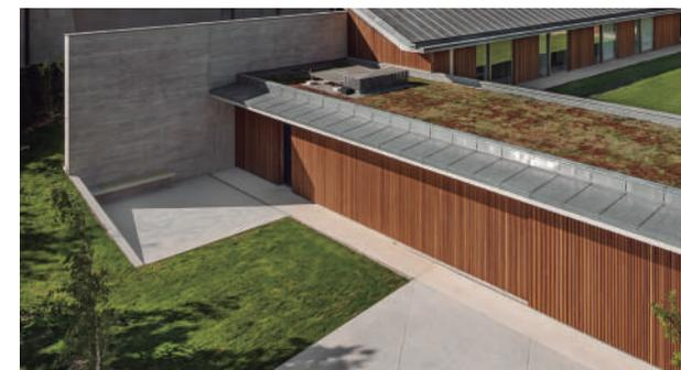
La **Cubierta Verde Urbanscape** es un sistema completo, que consiste en una membrana antirraíces, un sistema de drenaje con depósito de agua, un sustrato de lana de mineral de roca único y patentado y una capa de vegetación.
