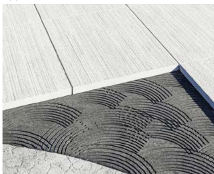
Aplicação em cimento ou betonilha
