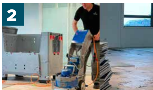
2 Nettoyage sur site, dépose et tri des dalles conformes au réemploi
