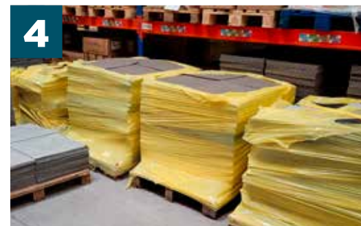
4 Mise à l'écart des dalles non réemployables destinées à la valorisation*
