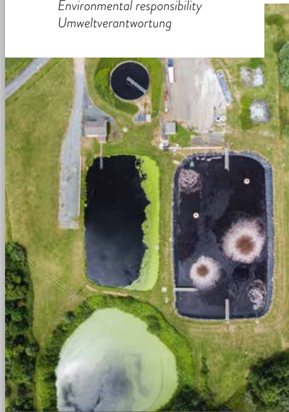
Station d'épuration sur notre site On-site water treatment plant / Kläranlage an unserem Standort
