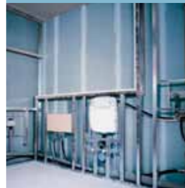
Instalación en el trasdosado de Knauf
