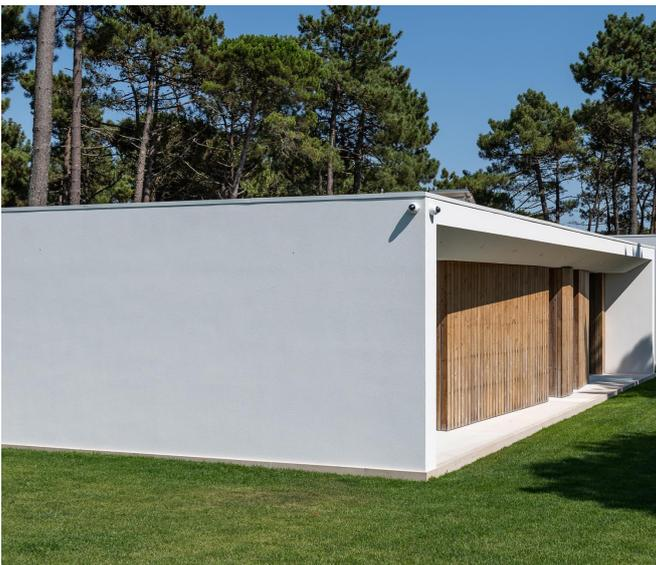
O weberrev pasta apresenta permeabilidade ao vapor de água e baixa absorção de água, garantindo simultaneamente a impermeabilização da fachada e a sua respirabilidade.
